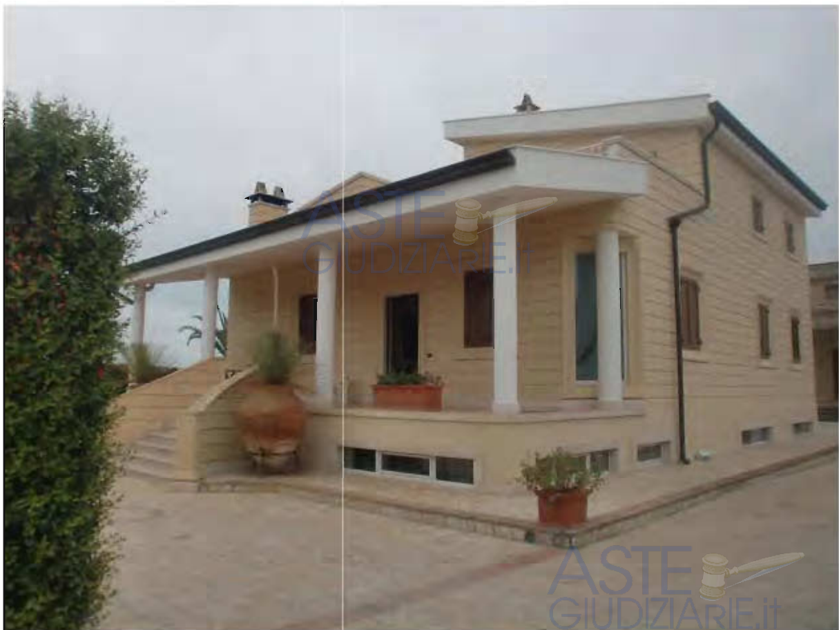
Prospetto Sud Est della villa in Gioia del Colle (Ba) Strada Vicinale della Chiusa, 1781/A
