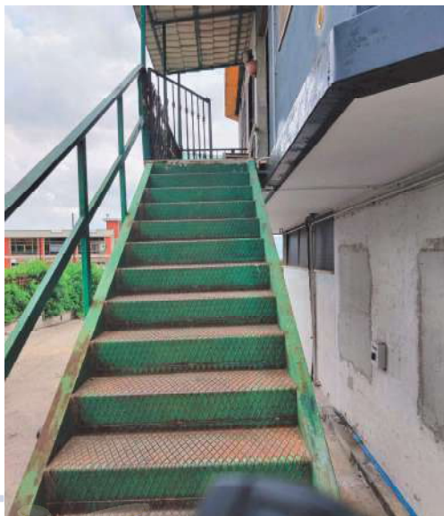
Foto 3: vista scala di accesso
