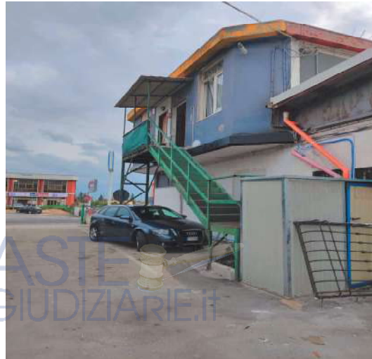
Foto 2: vista lato del piazzale esterno
