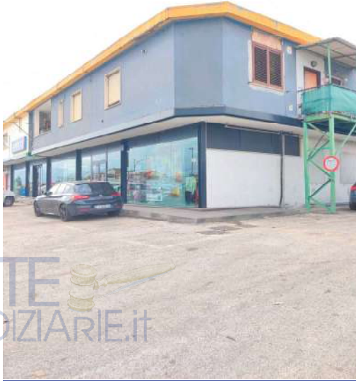
Foto 1: vista lato accesso di via Tiburtina Valeria
