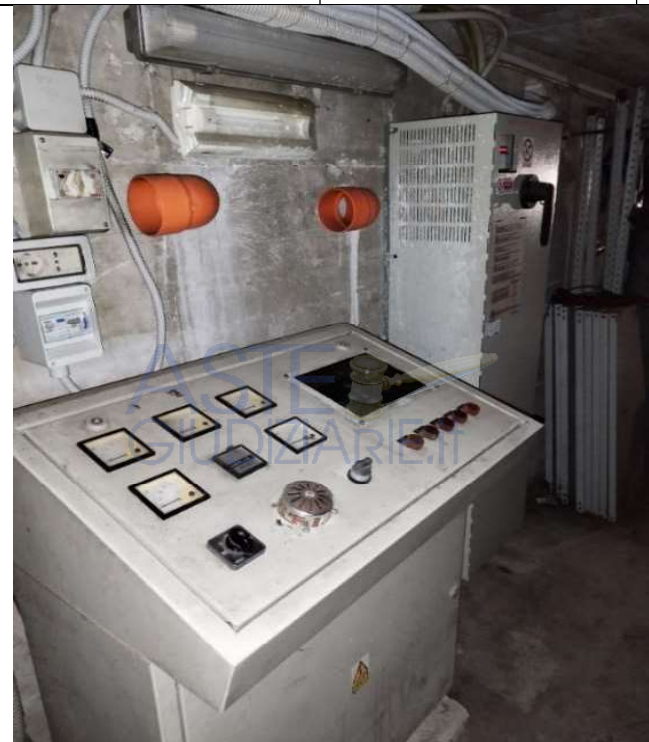
Foto 89- Quadro elettrico Gruppo elettrogeno da 45 kW
