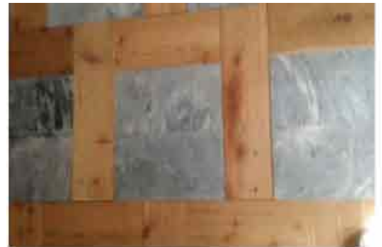
Particolare del pavimento
