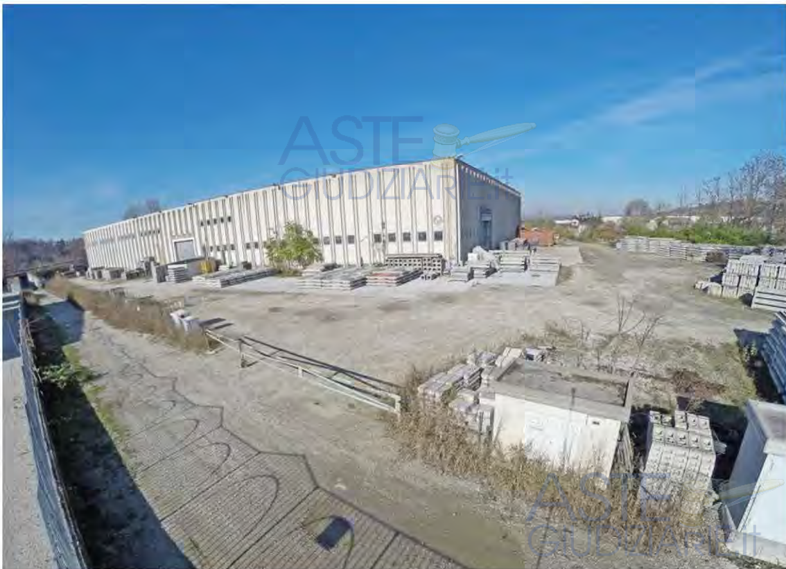
Fig. 2: ripresa fotografica del capannone prefabbricato ad uso produttivo e dell'area del piazzale di pertinenza – vedere rilievo fotografico ALLEGATO N.6
