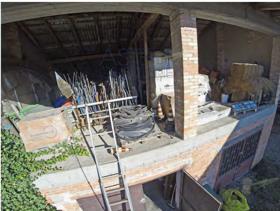
Fig. 7: ripresa fotografica fabbricato accessori – vedere rilievo fotografico
