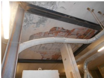
FOTO 4 – rinforzo strutturale con pilastri e travi in ferro in corrispondenza del cedimento della soletta di copertura (area di circa 15 mq)
