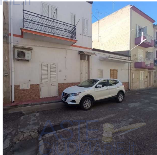
Accesso da via Trasimeno
