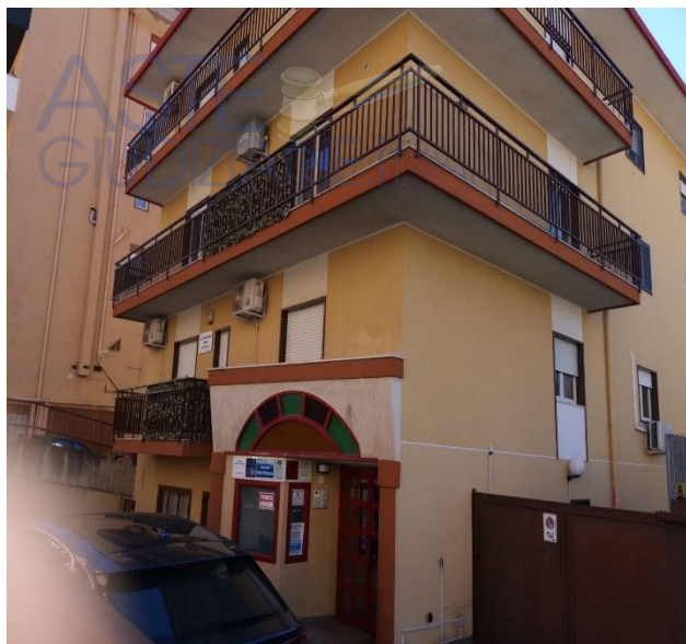
Foto n° 1 Portone accesso immobile
