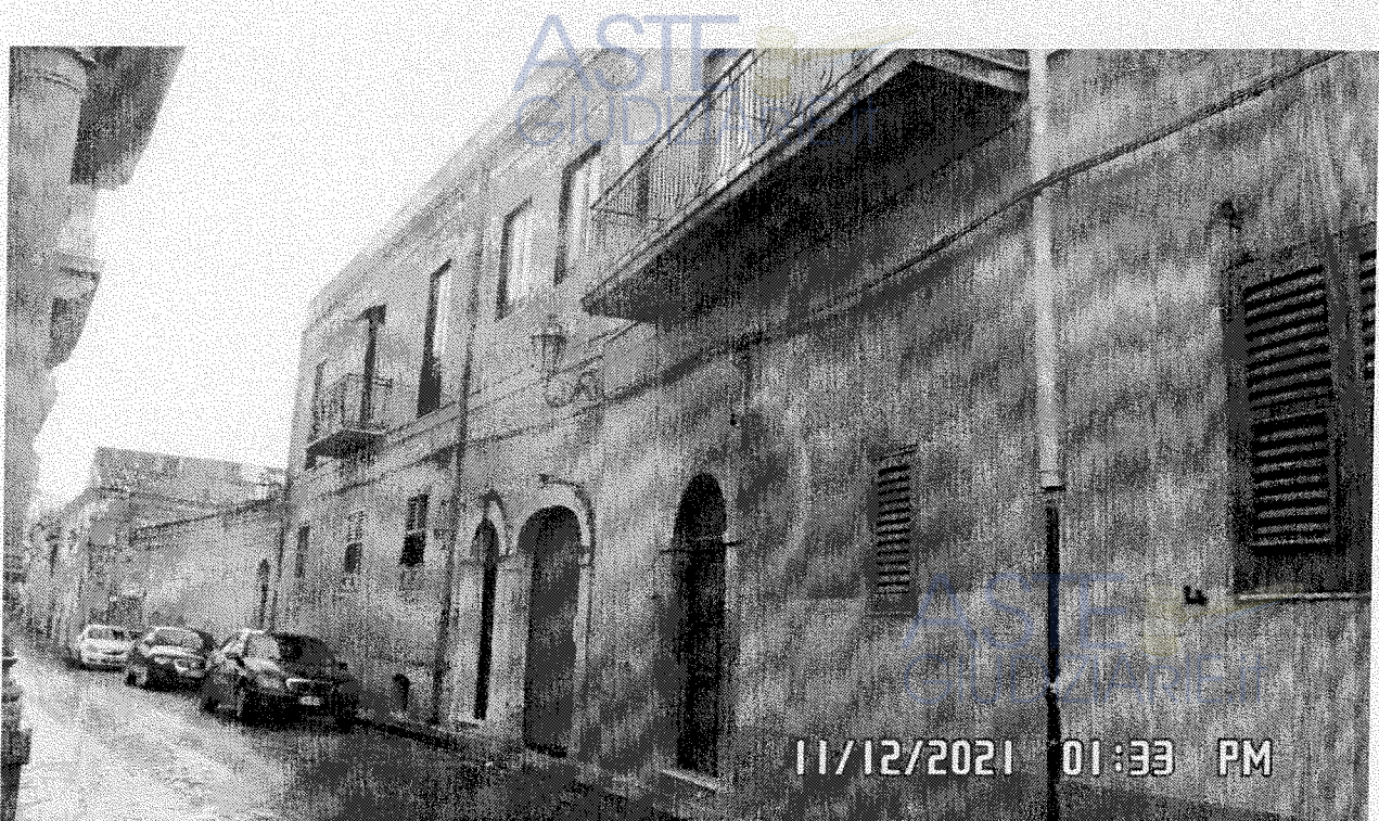
Foto 2 - Veduta del prospetto nord sulla via Dante n. 33
