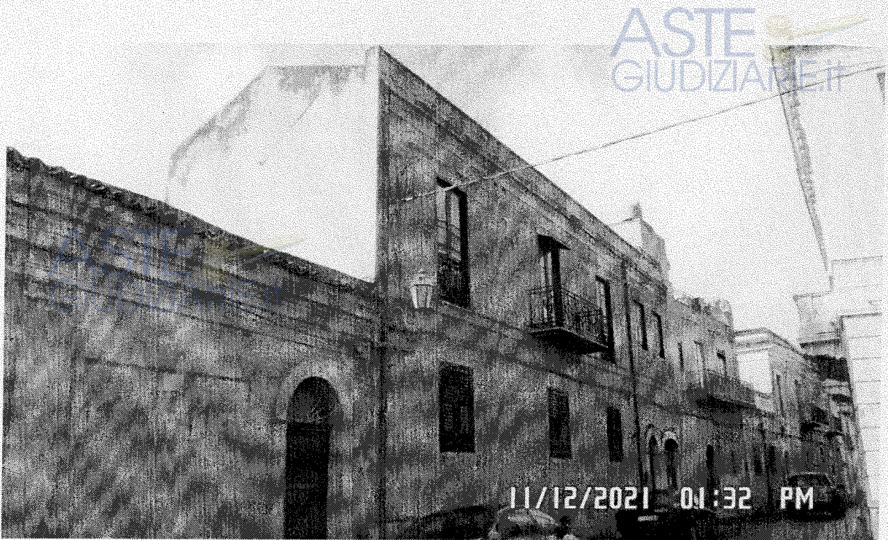
Foto 1 - Veduta del prospetto nord sulla via Dante n. 33
