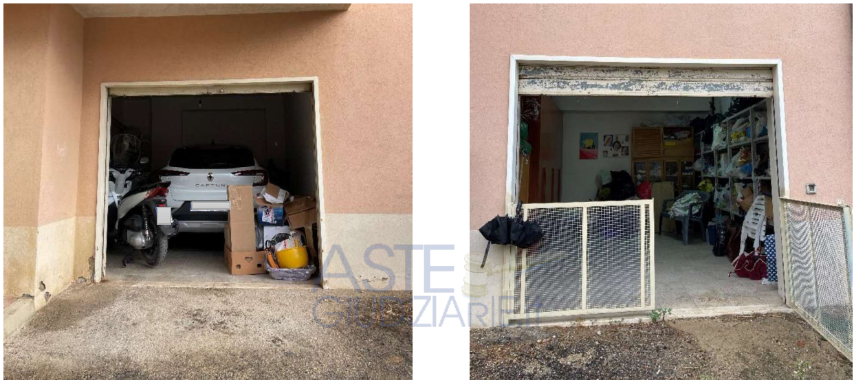
Foto dei magazzini
