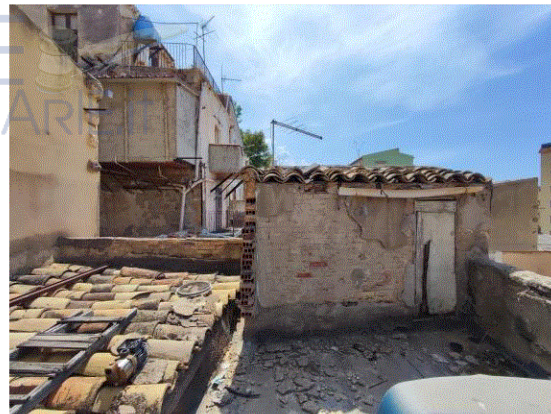
Foto 20 - copertura unità immobiliare (lato part 405)
