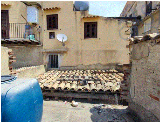
Foto 19 - copertura unità immobiliare (lato part 405)
