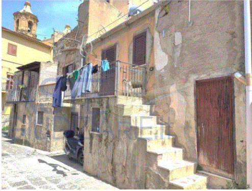
Foto 7 – Ingresso unità immobiliare oggetto di Esecuzione Immobiliare RG 203/2018 da vicolo San Francesco di Paola
