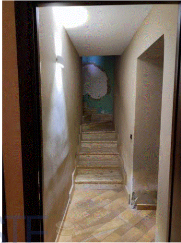
Foto 17 - scala interna di collegamento tra il piano terra e 1°
