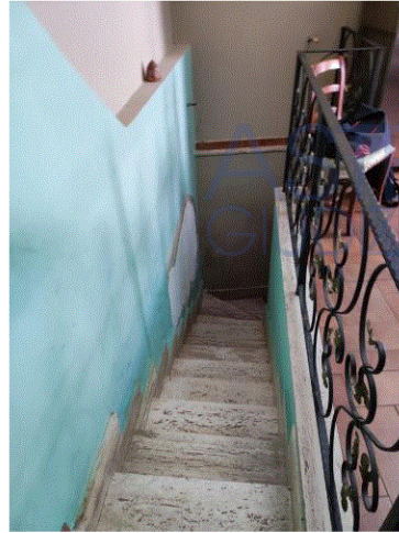
Foto 18 - scala interna di collegamento tra il piano 1° e terra
