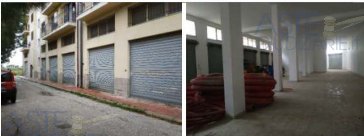
Figura 3 - A sx la vista esterna del prospetto Sud-Ovest, a dx vista interna del magazzino
