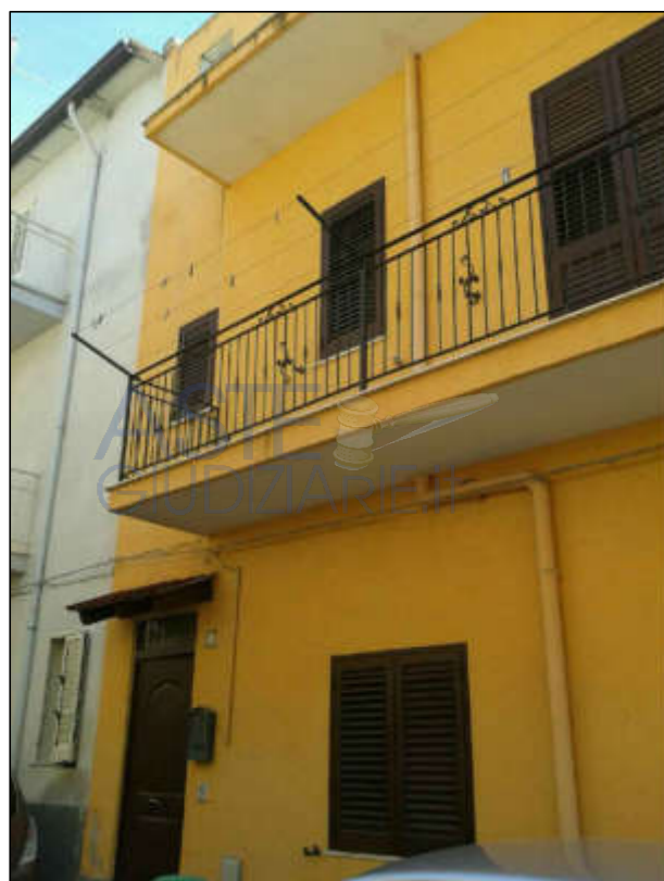
1) Prospetto principale su Via Ferri al civico 21
