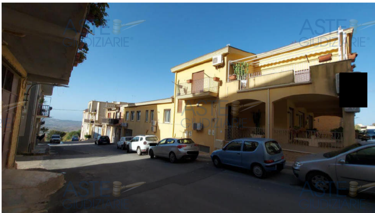
Foto 3 – prospetto laterale su via Colapuma
