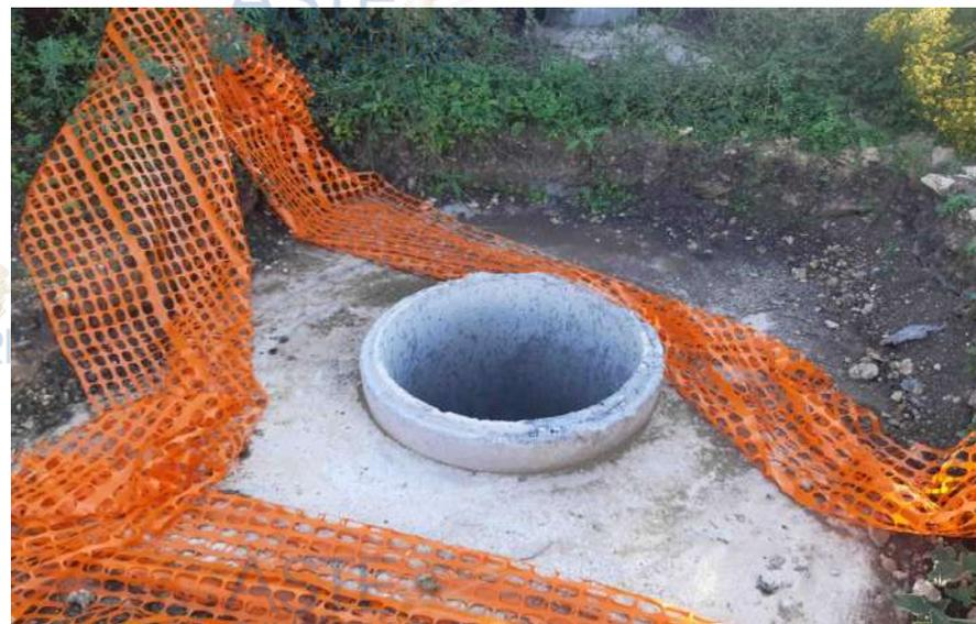
Foto 4 – Foro per palificazione elettrica
