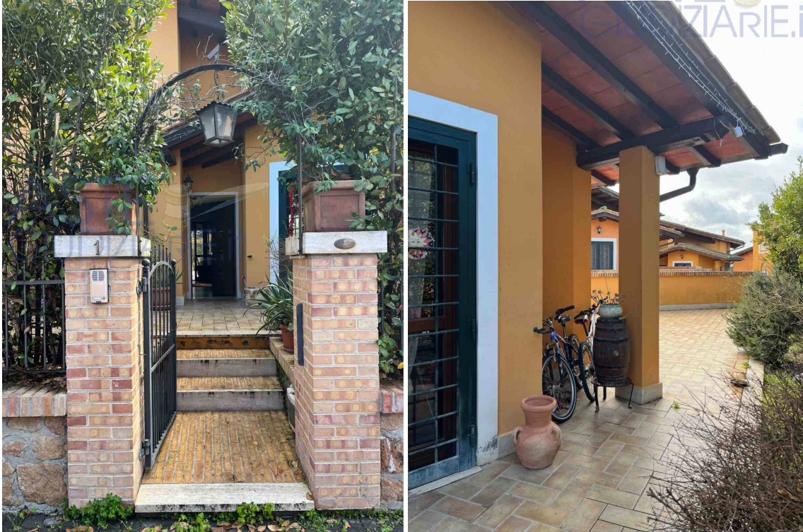
foto 3 - ingresso al villino
